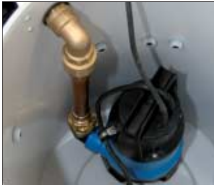
Tauchpumpe montiert 414/428/444
